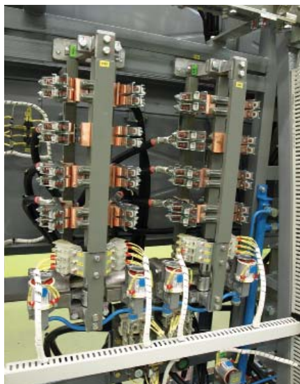
Zdalnie sterowane odłączniki silników typu MAO oraz panel sterowania.
