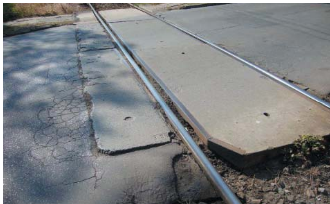
Przejazd kategorii C na linii nr 947 w km 1,405. Zły stan skrajnych płyt żelbetonowych i uszkodzony asfalt na dojeździe do przejazdu
