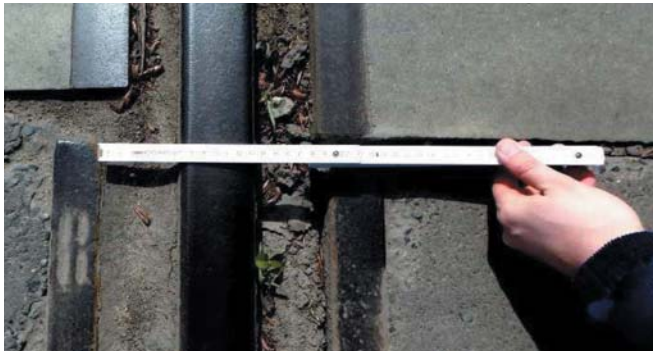
Przejazd kategorii D, w km 1,243 linia nr 503. Nierówne i zanieczyszczone żłobki na przejeździe kolejowo-drogowym Fot. NIK
