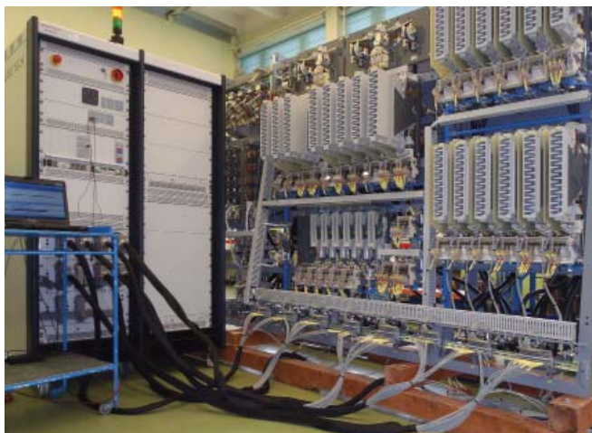
Fot. 5. Tester W454HV podczas sprawdzania szafy WN2 do lokomotywy EU07.
