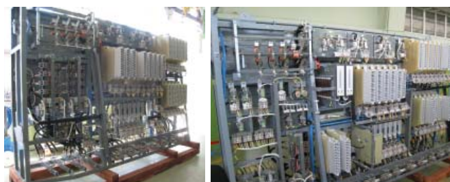
Fot. 2. Zmodernizowane szafy WN do naprawy rewizyjnej poziomu P4 lokomotywy EU/EP07.
