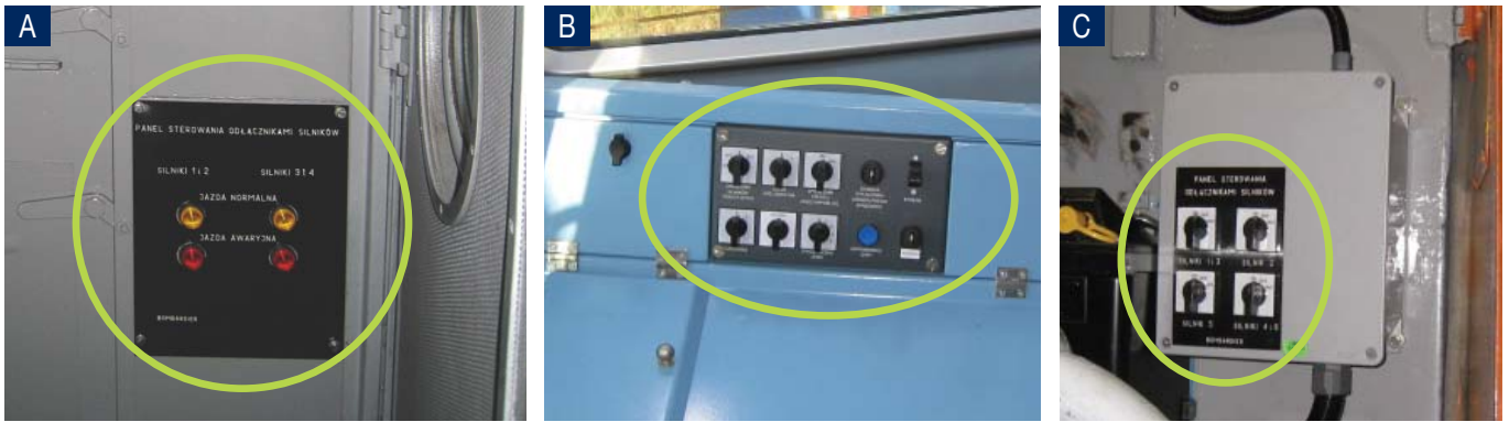
Fot. 3. Miejsce położenia panelu sterowania odłącznikami silników: a) na tylnej ścianie szafy WN2 (do lok. EU/EP07), b) na pulpicie maszynisty, c) na ścianie pomiędzy przedziałem maszynowym i szafą WN (w lok. ET22).
