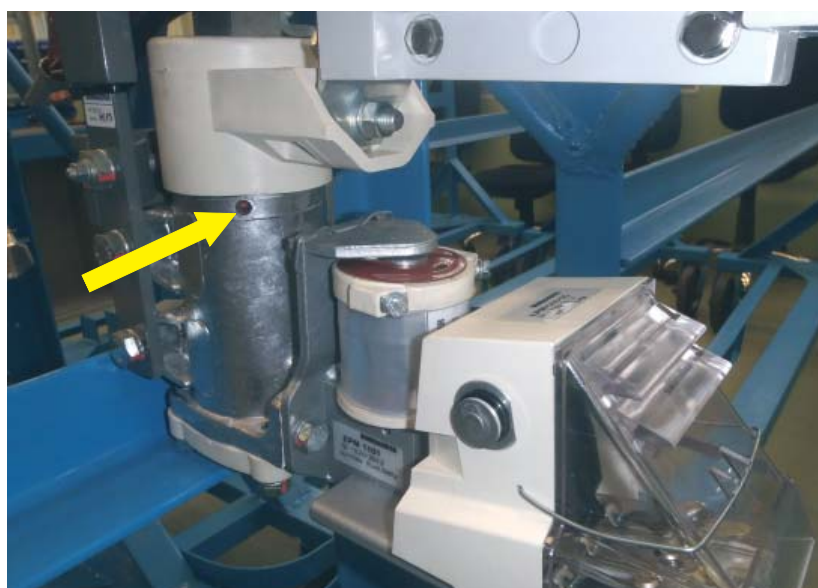
Fot. 1. Otwór w cylindrze przez który należy wstrzykiwać mieszaninę smarów.
