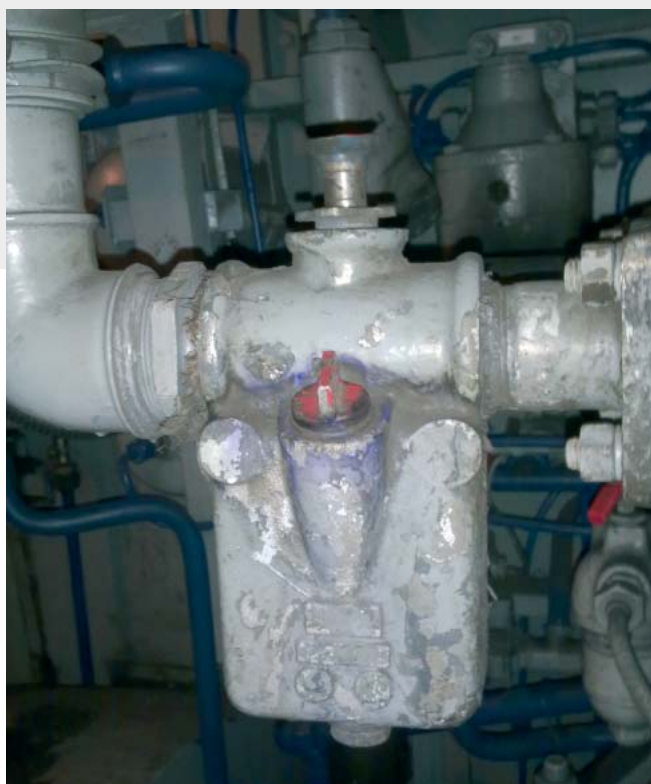
Fot. 3. Rozpylacz alkoholu o pojemności 0,7 l stosowany dotychczas.
